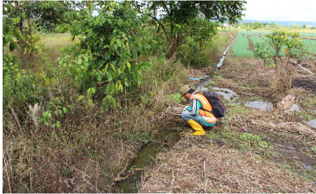
Gambar 32 Saluran Air di Kebun di Desa Tinimbo
