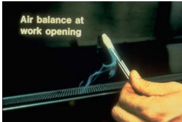
Gambar 11. Uji aliran udara dengan tes asap
